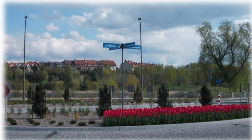
ul. Polna Droga – ul. Wałbrzyska - rondo
